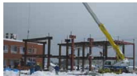
鉄骨建方の作業が始まりました。
