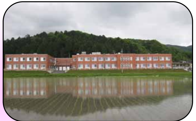
増床ユニット棟の外観(左側の棟)
